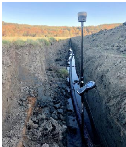
Inmätning vattenledning
