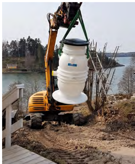
Att lyfta ner avloppspumpens hölje kräver sin maskin och förare.
