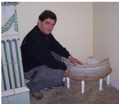
Detta är botten på ugnen som man måste göra först när man bygger/renoverar en kakelugn
