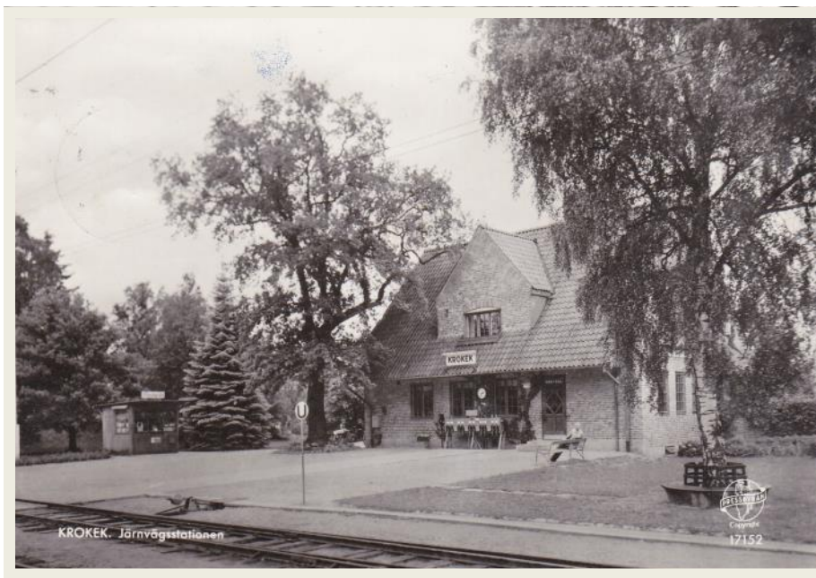
Stationshuset med ställverk
