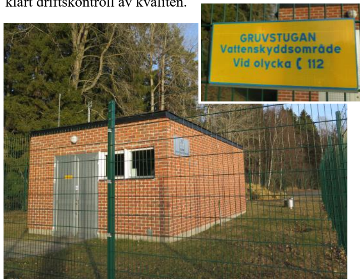
Vattenverket vid Gruvstugan
