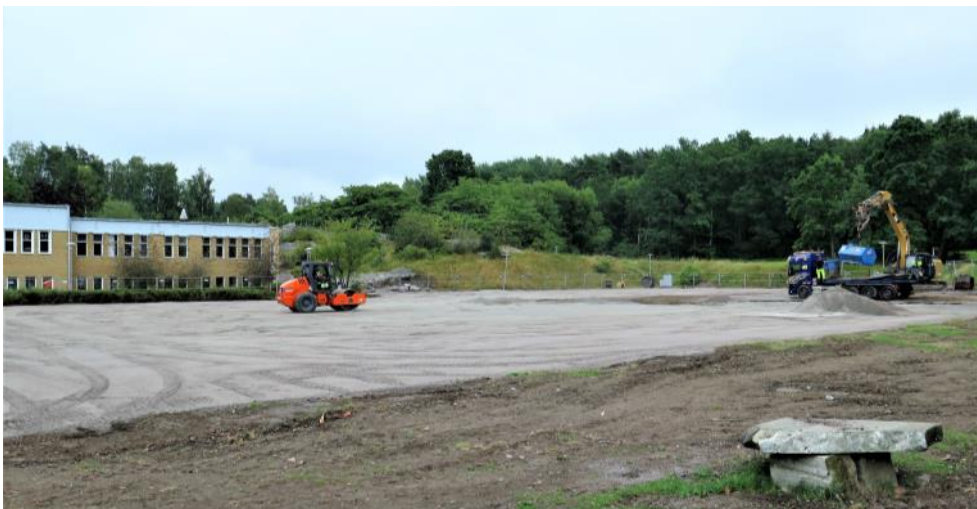
B och C-husen är jämnade med marken. Här ska en helt ny skola byggas!
