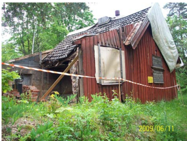
"Borrsmédjan" före renoveringen
