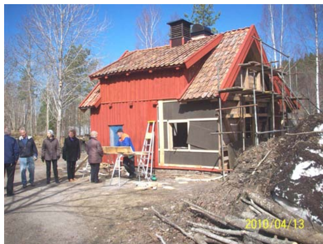
"Borrsmedjan" under renovering
