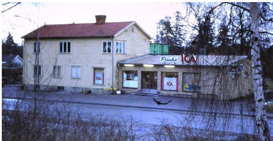
Tidig bild av ICA-fastigheten före ombyggnad
