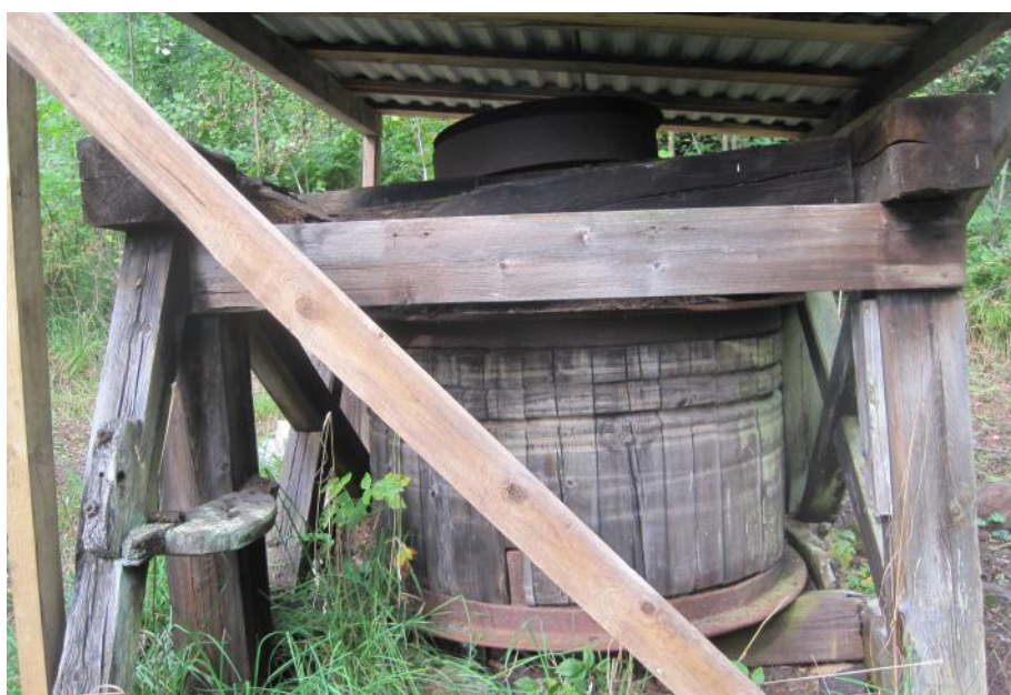
Vinschtrumman med bromsanordning
