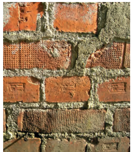
Äldre tegelvägg med märket Ti
